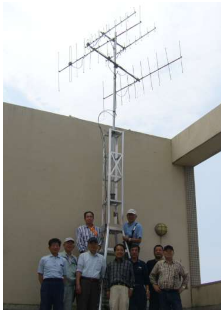
2012年ビーチホールまがたま 屋上に災害対策用のアンテナ建設
