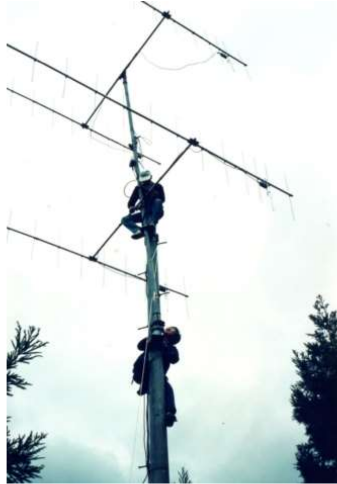
1991年 パンザマスト建設
